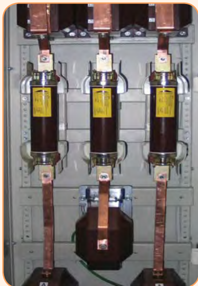
Внутренняя установка предохранителей
