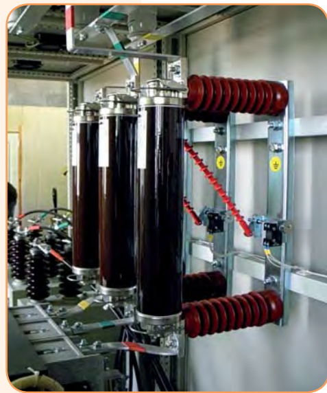
Установка внутренних держателей предохранителей*
